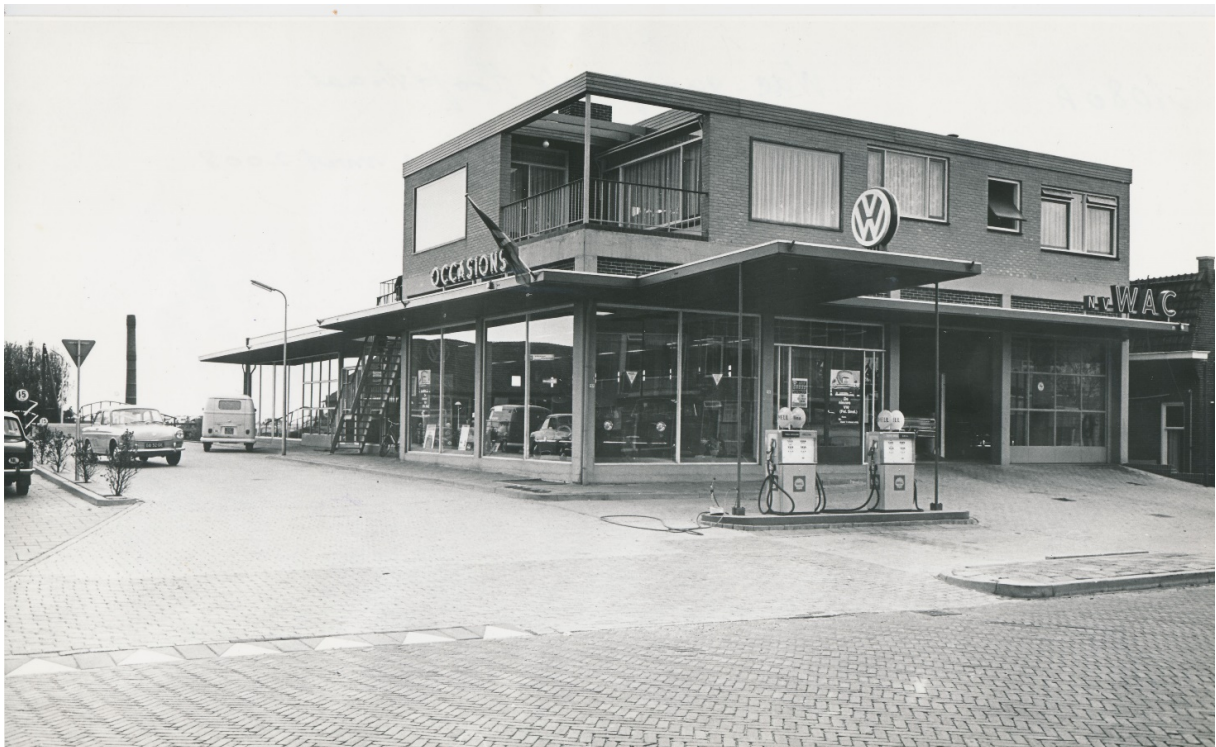
WAC garage aan de Hoofdstraat met de brugoprit naar boerderij Blijvenburg.
